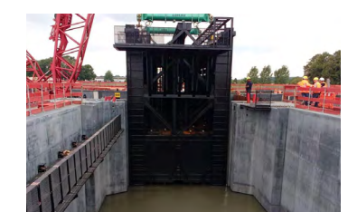
PUERTAS DE ESCALERA
