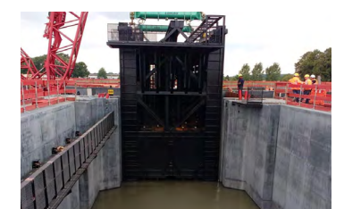
PUERTAS DE ESCALERA
