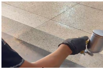
RENOVACIÓN DEL ACABADO
