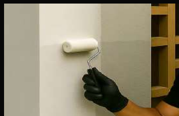
SOBRE PINTURA DE MURO
