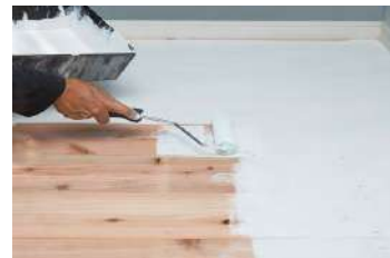
PEMBARUAN LANTAI KAYU
