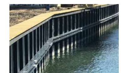
PAREDES DE COMPORTA
