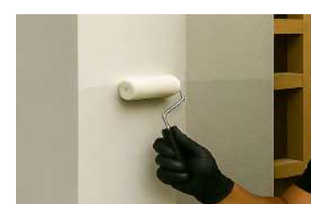
SOBRE PINTURA DE MURO
