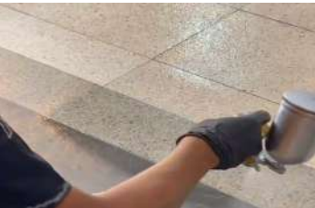
RENOVACIÓN DEL ACABADO
