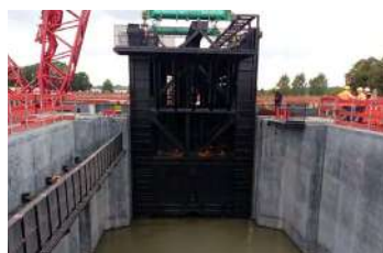
PUERTAS DE ESCALERA
