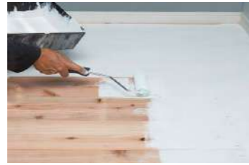
PEMBARUAN LANTAI KAYU
